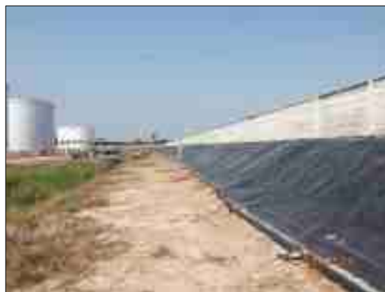
รูปที่ 3-20 การปรับปรุงคันดินรอบพื้นที่ของโครงการคลังน้ำมันพิจิตรเพื่อลดการชะล้างพังทลายของดิน
